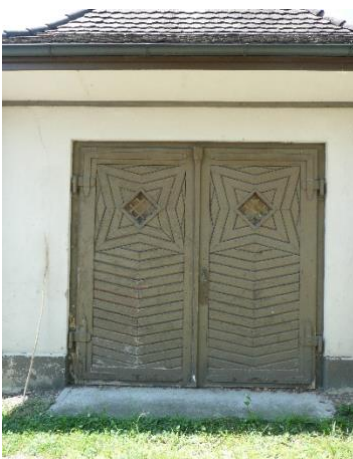
Waschhaus, Detail Garagentor. [Fotografie MEC 2014]
