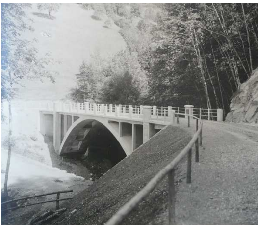
Klägertobelbrücke, historische Fotografie wohl kurz nach Fertigstellung (undatiert). [Gemeindearchiv Kaltbrunn]
