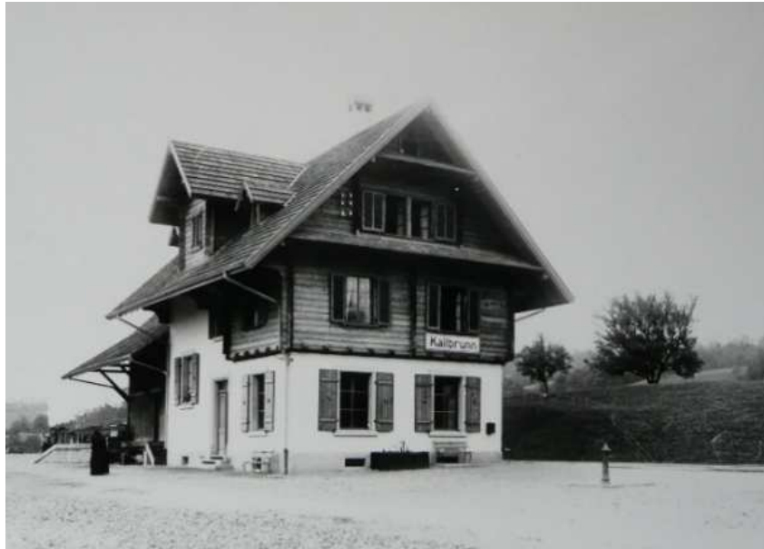
Stationsgebäude mit Güterschuppen, Fotograf A. Lichtensteiger, undatiert. [Kantonale Denkmalpflege St. Gallen]
