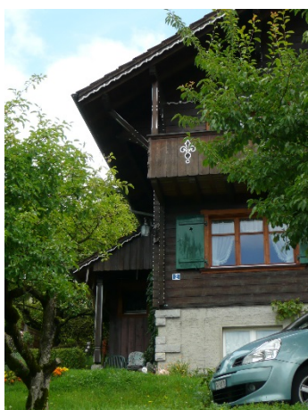
Südwestlicher Hausbereich. [Foto MEC 2014]
