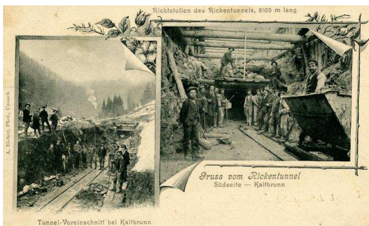
Bau des Ricketunnels (Ansicht Südseite), Postkarte 1904. [Staatsarchiv St. Gallen]
