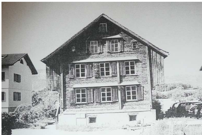
Gasterstrasse 46, Zustand vor 2004 (Fotografien aus den Bauakten).
