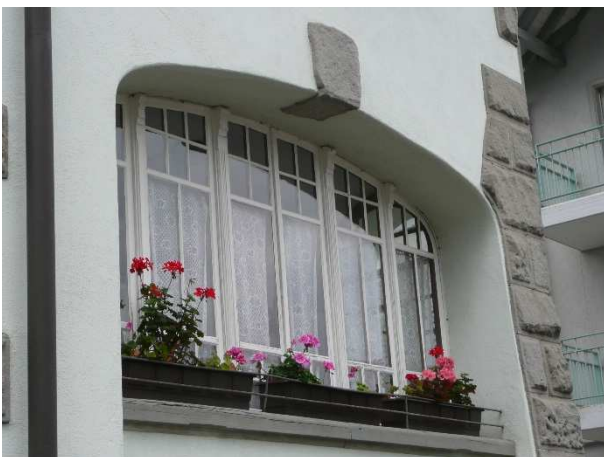
Uznacherstrasse 7, Detail Nordfassade. [Foto MEC 2014]
