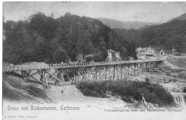
Rickentunnel-Bahnbau, Transportgerüst über den Kaltbrunner Dorfbach, Foto ca. 1904 - 1910, Fotograf A. Eicher Uznach. [Staatsarchiv St. Gallen]
