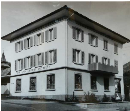
Undatierte Aufnahme, vermutlich kurz nach Fertigstellung, Fotograf Paul Schäfer aus Weesen. [Kantonale Denkmalpflege St. Gallen]
