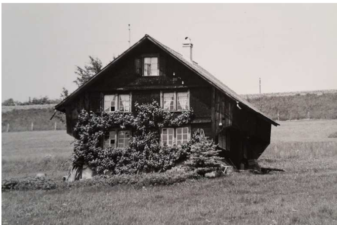
Gjuch 343, Zustand vor dem Umbau 1978. [Foto Ortsbildinventar 1977]
