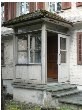
Hauseingang mit Windfang. [Foto MEC 2014]
