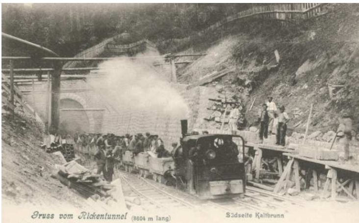
Rickentunnel-Bahnbau, Südseite, Werkzeug mit mitfahrenden Arbeitern, Foto ca. zwischen 1904 und 1910, Fotograf A. Eicher Uznach. [Staatsarchiv St. Gallen]
