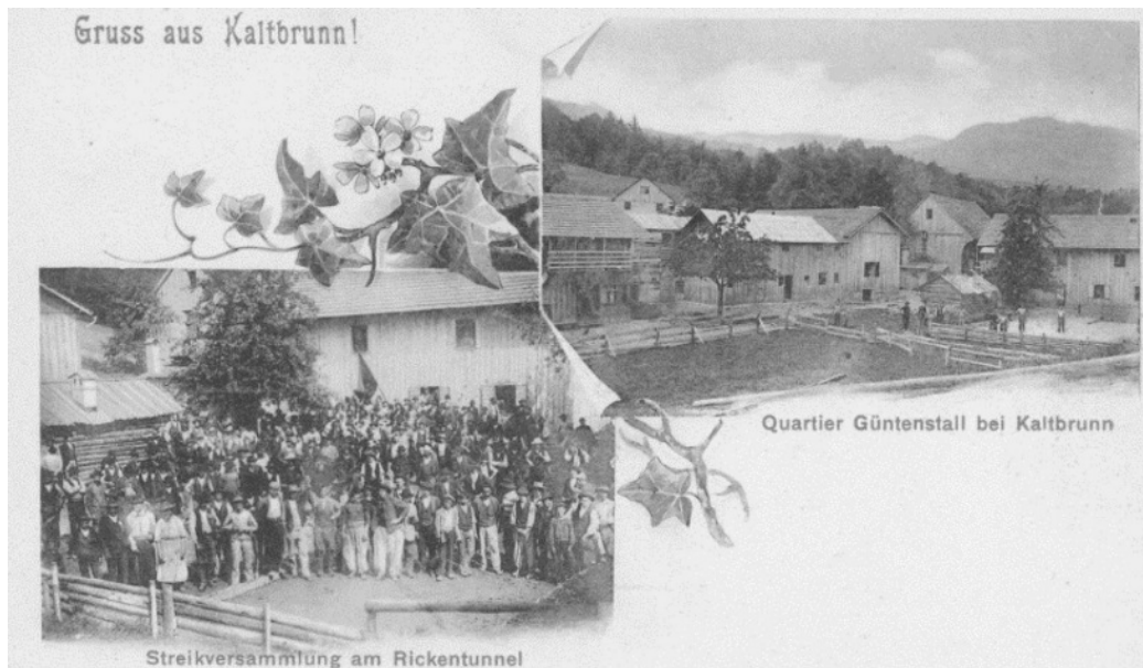
Rickentunnel-Bahnbau, links Streikversammlung am Tunnel, rechts Quartier in Güntenstall, Postkarte ca. 1904. [Staatsarchiv St. Gallen]
