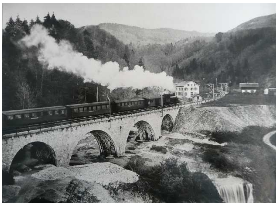
Rickentunnel-Bahnbau, Fertiggestellte Eisenbahnbrücke über den Kaltbrunner Dorfbach, Foto undatiert (nach 1910). [Gemeindearchiv Kaltbrunn]
