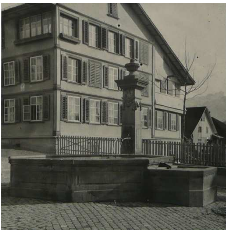
Dorfbrunnen, Zustand 1932, Fotograf Blöchlinger. [Kantonale Denkmalpflege St. Gallen]
