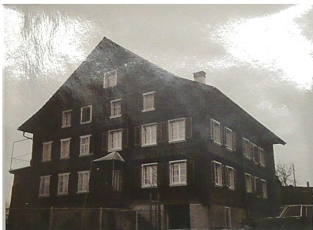
Bauernhaus Gasterstrasse 88, Zustand vor der Restaurierung 1978. [Kantonale Denkmalpflege St. Gallen]
