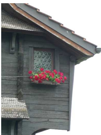
Strassenseitige Hauptfassade, Detail Laube. [Foto MEC 2014]
