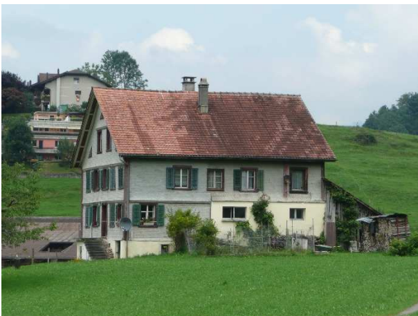
Bruggacker 243, südöstliche Fassade. [Foto MEC 2014]
