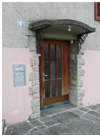
Detail (GVA-Nr. 937), original gestalteter Eingang (West- fassade). [Foto MEC 2014]
