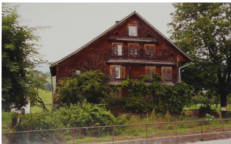
Hof Müllisberg, Südfassade vor der Restaurierung 1995-1999. [Kantonale Denkmalpflege St. Gallen]
