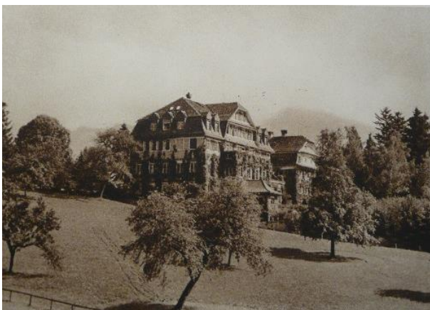
Ansicht gegen Norden, Aufnahme vermutl. 1930. [Hof-Zeitung, No. 48.]
