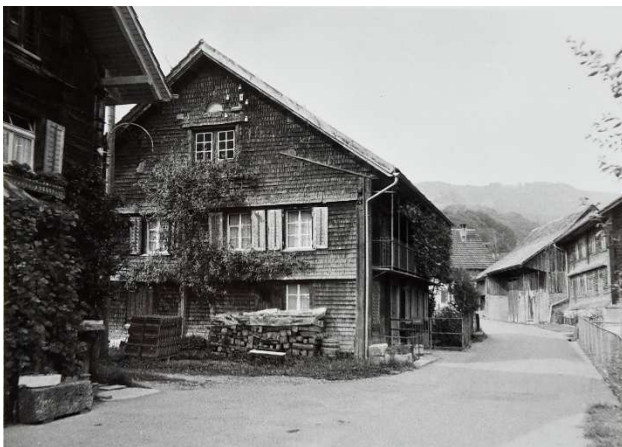
Bauernhaus Wiedenstrasse 2, Abbildung vor Erneuerung der Südfassade. [Foto Ortsbildinventar 1977]
