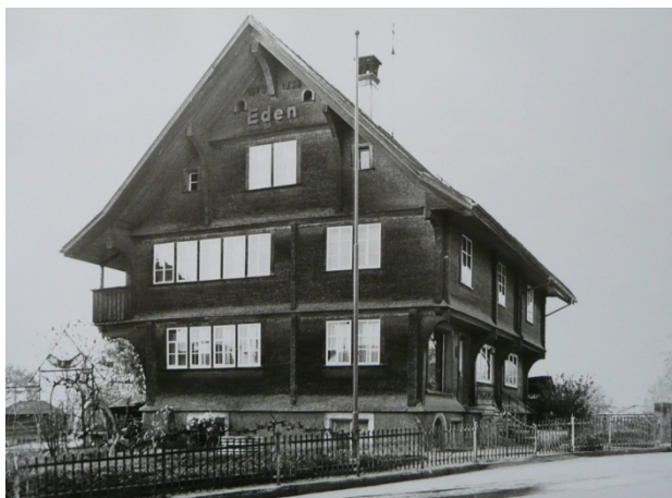
Ehem. Kaplanei, Fotograf Bernhard Anderes, 1969. [Kantonale Denkmalpflege St. Gallen]
