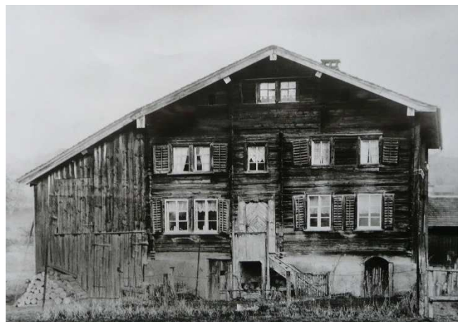
Fischhausen, Thuoten-Haus (GVA-Nr. 361), Baujahr 1675. Zustand vor Umbau 1969, Fotograf Bernhard Anderes. Heute praktisch zerstört. [Kantonale Denkmalpflege St. Gallen]
