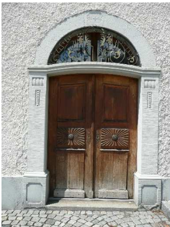
Bauzeitliches Sandsteinportal an der Ostfassade mit schmiedeeisernem Ziergitter und dekorativen Türflügeln. Sturz datiert 1801. [Foto MEC 2015]
