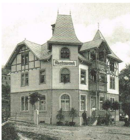
Historische Fotografie, Restaurant Bahnhof. [Frei, S. 163.]
