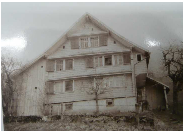
Sommerig 188, Fotografie vor Umbau 1980. [Kantonale Denkmalpflege St. Gallen]
