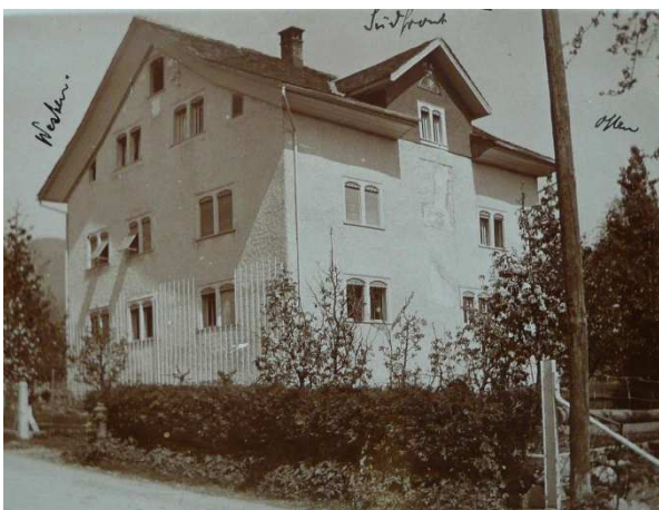
Sogenanntes Steinhaus, Fotografie undatiert, jedoch vermutlich nach 1911. [Kantonale Denkmalpflege St. Gallen]
