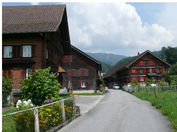
Kleine intakte Baugruppe in der Wilen; ortsbildprä- gendes Ensemble. [Foto MEC 2014]
