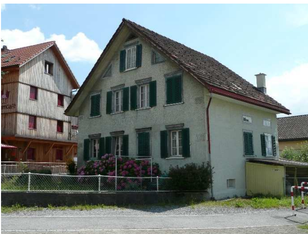
Wohnhaus «Daheim», Blickrichtung Südosten. [Foto MEC 2015]
