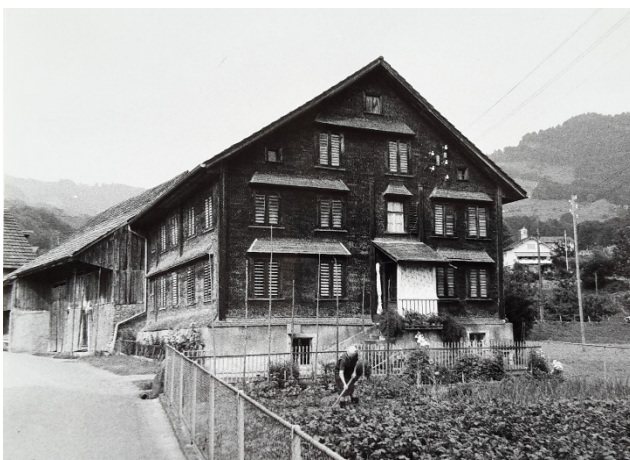
Bauernhaus Wiedenstrasse 5 mit rückwärtig angebauter Stallscheune. [Foto Ortsbildinventar 1977]
